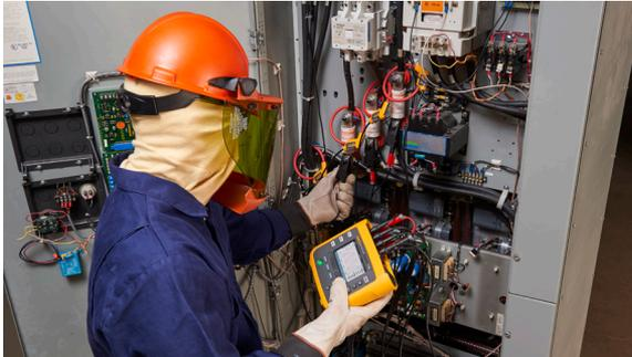
Einsatz eines dreiphasigen Power-Loggers Fluke 1738 für Energiestudien an einem mechanischen System
